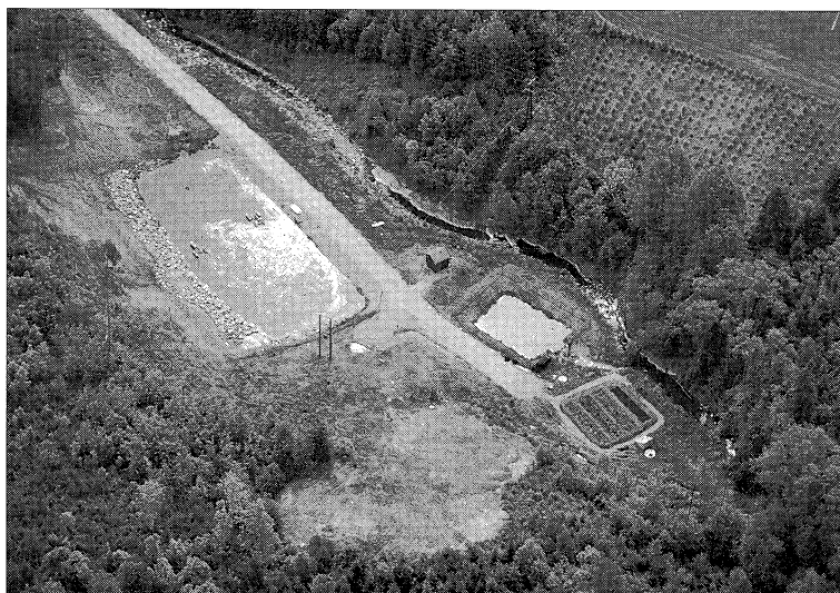
Figur 2. Flyfoto av Bølstad renseanlegg
