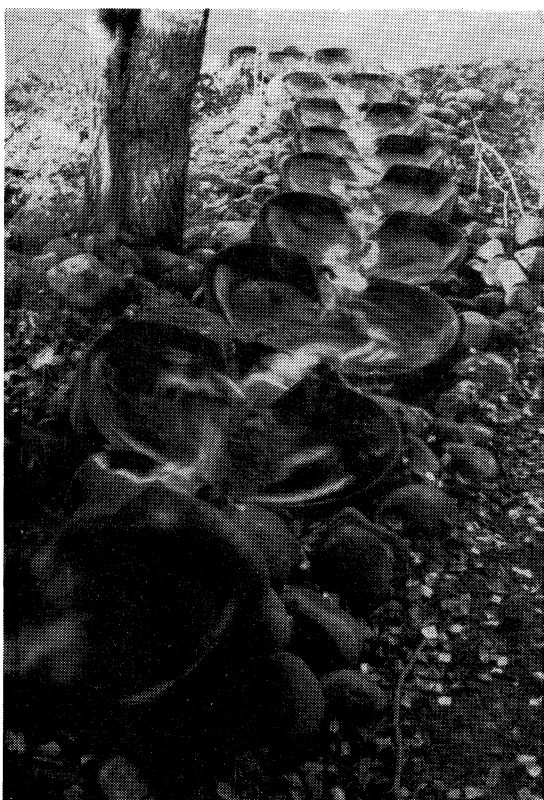
Figur 2. Lufting ved hjelp av strømningsformer i Solborg biodamanlegg.
