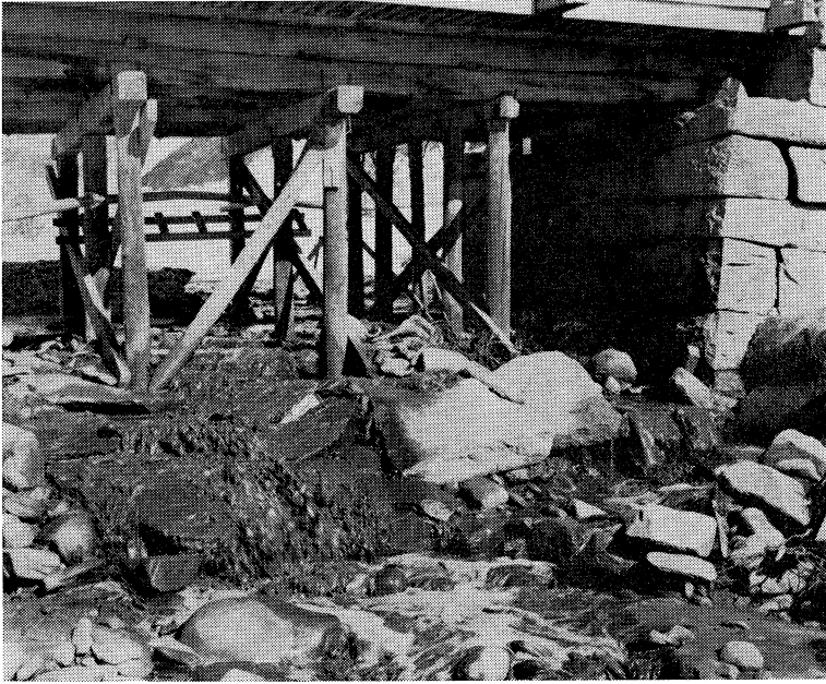
Avløpsvann fra oppredningsverk.
