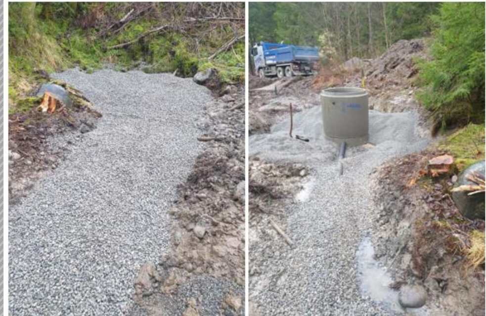
Figur 4. Gropa er ca. 3 m dyp, og de stedege massene rundt består i hovedsak av tette masser av silt og finsand. I bunn er det lagt ca. 1 m med vasket singel/pukk (Ø8-16 mm). Laget med vasket singel/pukk går ca. 40 cm opp på den nedre kumringen.
