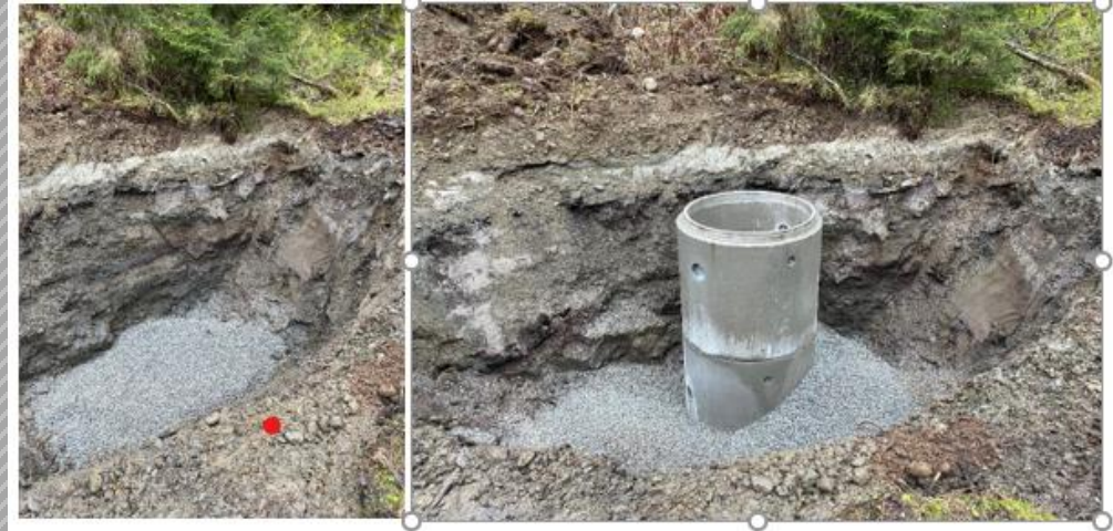
Figur 4. Gropa er ca. 3 m dyp, og de stedege massene rundt består i hovedsak av tette masser av silt og finsand. I bunn er det lagt ca. 1 m med vasket singel/pukk (Ø8-16 mm). Laget med vasket singel/pukk går ca. 40 cm opp på den nedre kumringen.
