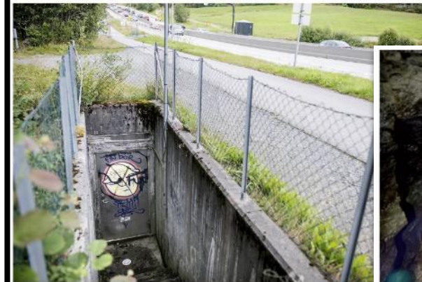
Den aktuelle drikkevannsprøven ble tatt i anlegget bak denne dæren. Foto: SKJALG EKELAND
