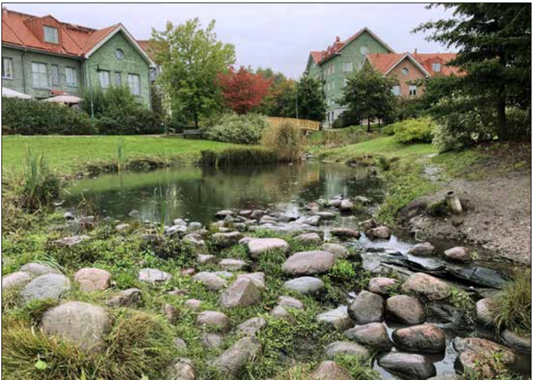
Figur 7. En åpen bekk ble lagt mellom husene og ble utgangspunktet for Illenpuiston park i Vantaa kommune, fordi byggegrunnen var for ustabil for en bekkelukking, som var den opprinnelige planen (foto: Braskerud).
