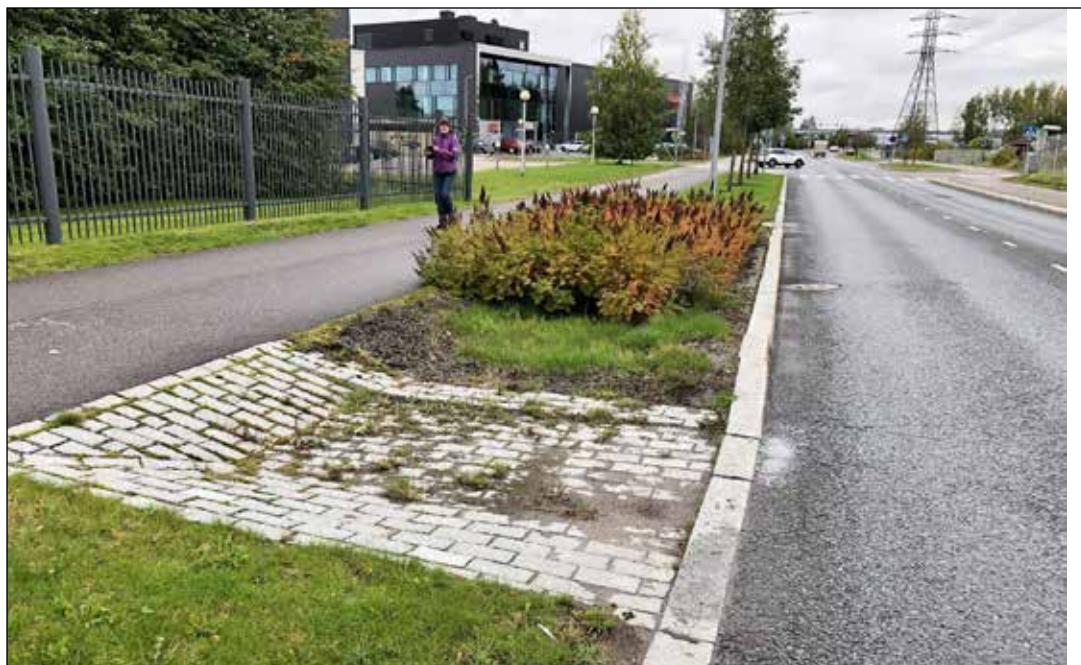
Figur 3. Regnbed med grunt sedimentasjonskammer i innløpet som er lett å rengjøre maskinelt (foto: Braskerud). Tiltaket kan lages smalere om det er ønskelig.
