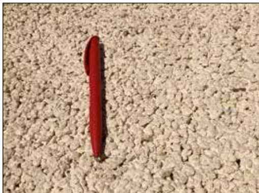
Figur 7. Hvitt permeabelt betongdekke ble brukt på nye fortau når boulevard Eugène Réguillon skulle oppgraderes. Erfaringer viser at dekket kan håndtere 10-års hendelsen, selv om det er 90 % tett. Varigheten er beregnet til 30 år uten spesielt vedlikehold, men her brukes trolig ikke strøsand. Hvit farge ble trukket frem som et positivt tiltak mot oppheting.
