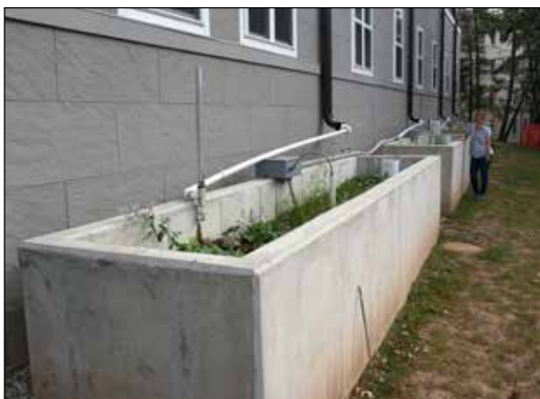
Figur 9. Fire mini-regnbed (å 2,5 m 2 ) mottar vann fra 444 m 2 takflate. Ca. 8,3 mm fordampet daglig i sommerhalvåret (venstre bilde av Elizabeth Fassman-Beck).
