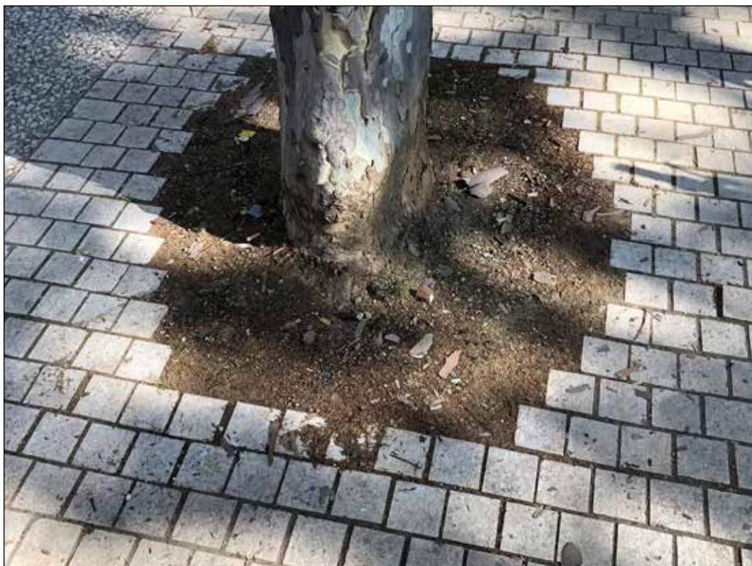
Figur 8. Permeable dekker gir gatebelegningen et nytt spennende uttrykk. En fordel med belegningsstein rundt trær er at de kan fjernes etter hvert som treet vokser. Merk at her kan vannet renne til treet.
