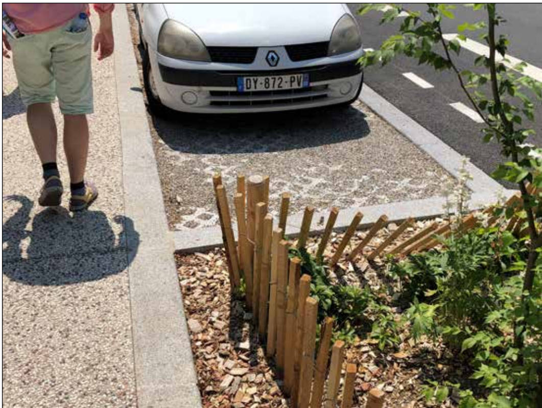
Figur 6. Vegen og fortauet drenerer mot -permeable P-plasser og trær. Opprinnelig var det gress i P-plassene, men det syntes folk virket uryddig, og det ble derfor fjernet.
