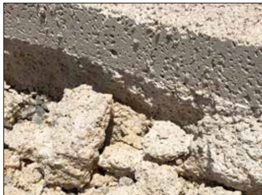
Figur 7. Hvitt permeabelt betongdekke ble brukt på nye fortau når boulevard Eugène Réguillon skulle oppgraderes. Erfaringer viser at dekket kan håndtere 10-års hendelsen, selv om det er 90 % tett. Varigheten er beregnet til 30 år uten spesielt vedlikehold, men her brukes trolig ikke strøsand. Hvit farge ble trukket frem som et positivt tiltak mot oppheting.
