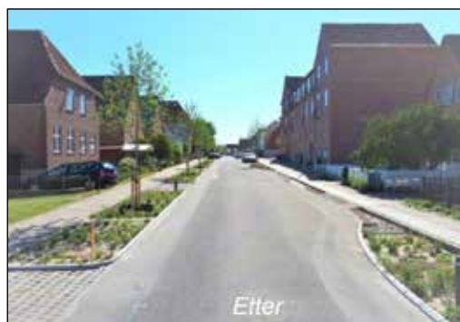
Figur 10. Rehabiliteret gate i Odense der regnbed og andre LOD-teknikker er benyttet for å separere overvann fra fellesledningene og trygge bebyggelsen ved store nedbørhendelser (bilder fra Martin W. Sørensens presentasjon, VCS-Denmark).
