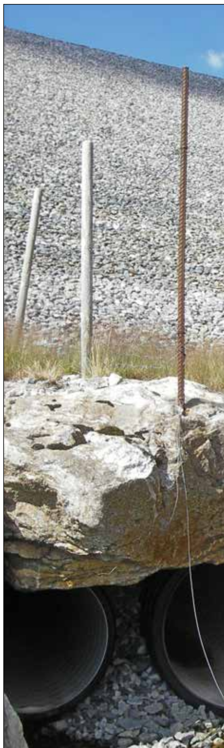
Leakage from Svartevassdammen. (illustrasjonsbilde)
