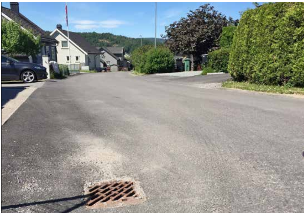
Foto 1. Lokal vei i Porsgrunn med ensidig fall der overvannet er separert fra spillvannet. Overflata er tilrettelagt som flomvei på venstre side, for tilfellene der nedløpsristene er tette eller rørkapasiteten er oversteget.
