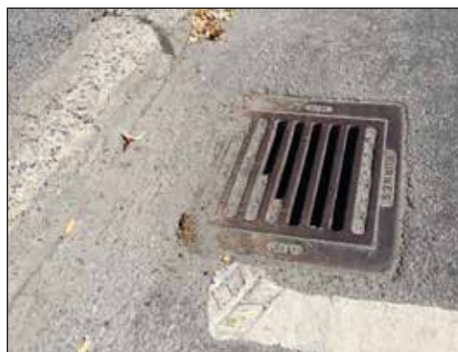
Foto 3. Sandfang som leder vann til fellesledninger vil få redusert funksjon om nedløpsrista monteres litt fra fortauskanten. Et viktig spørsmål er hvor mange sandfang som egentlig er nødvendige?
