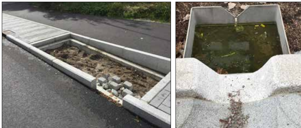
Foto 5. Veivannet renner rett inn i regnbedet. Trolig en effektiv måte å fordroye og rense overvann, men driften blir komplisert ved at søppel fordeles i regnbedet. Kanskje en stålkasse i innløpet ville redusere vannets eroderende kraft, samle søppel og lette driften? Regnbedet vil beplantes seinere.
