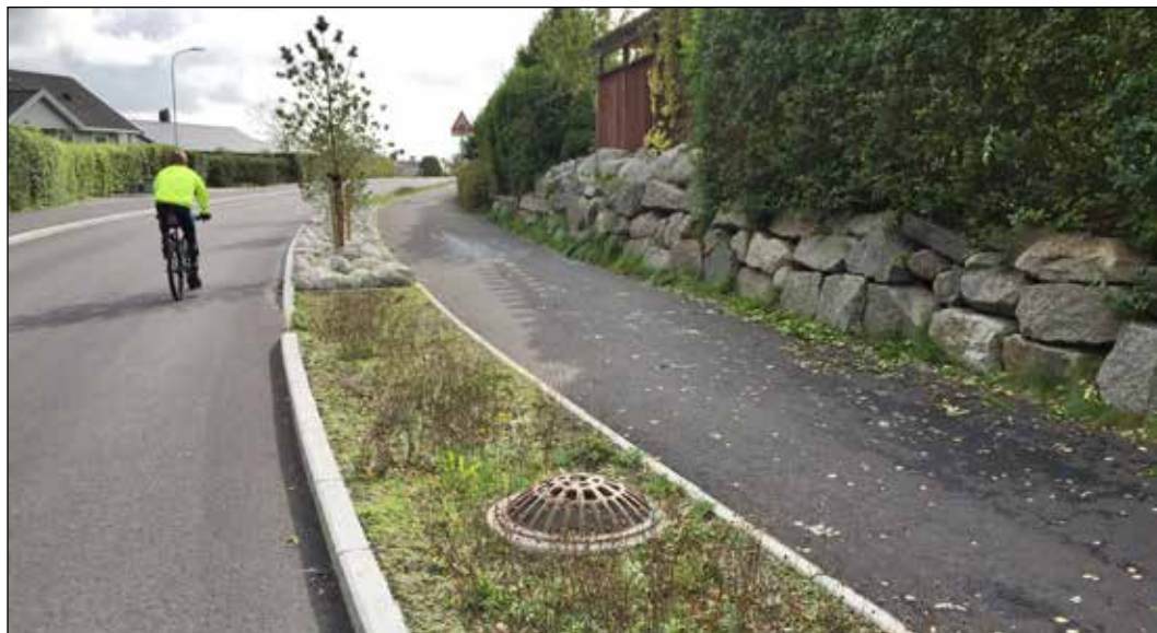
Foto 6. Vadi bestående av 6 koblede infiltrasjonsgrøfter med forskjellig oppbygning og plantevalg i Sandnes. Overvannet renner inn fra fortau og veibanen.
