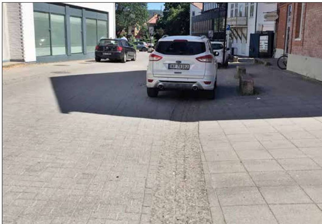
Foto 2. Gate i Porsgrunn har fått V-formet overflate. Flomvannet vil følge gata og i mindre grad ødelegge husene på begge sider.
