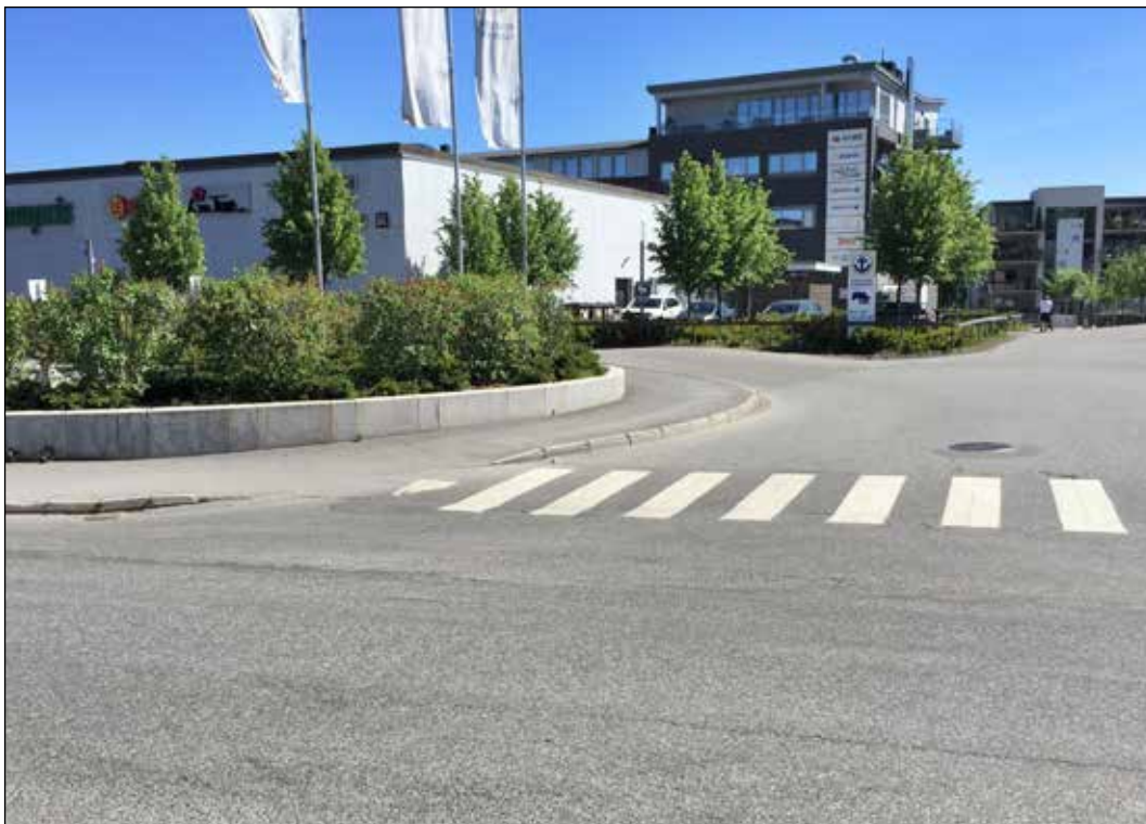
Foto 4. Flomvei fra venstre og høyre ville oversvømt kjøpesenteret i Porsgrunn, om ikke den beplantede støttemuren og «fartsdumpe» i innkjørselen var satt opp. Nå ledes overvannet rett frem mot høyre og til elva.
